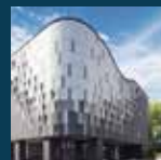
施工完成示意
