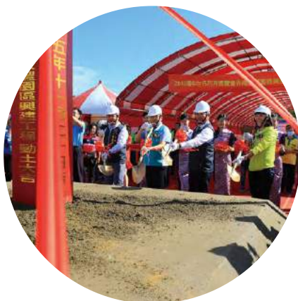
花博外埔園區已經動土， 展開相關建設工程。
