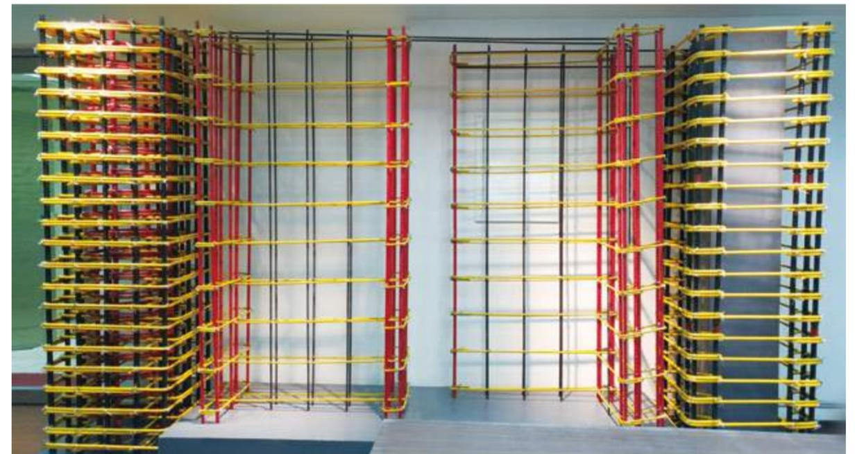
上圖中黃色水平鋼筋皆是以一根鋼筋不間斷，連續彎折成一體成形的箍筋形狀。可以大幅的提升施工品質與施工速度，使得柱、牆體更安全、更穩固可以大幅的提升施工品質與施工速度，使得柱、牆體更安全、更穩固。
