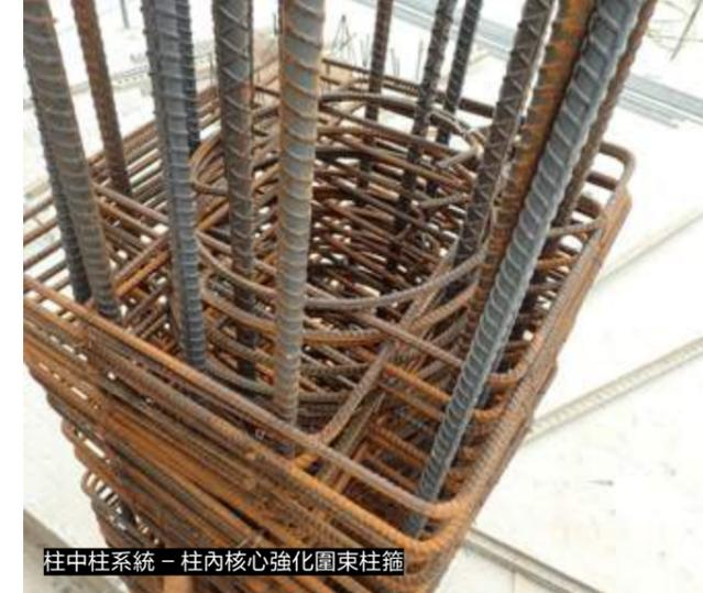
柱中柱系統 - 柱內核心強化圍束柱箍
