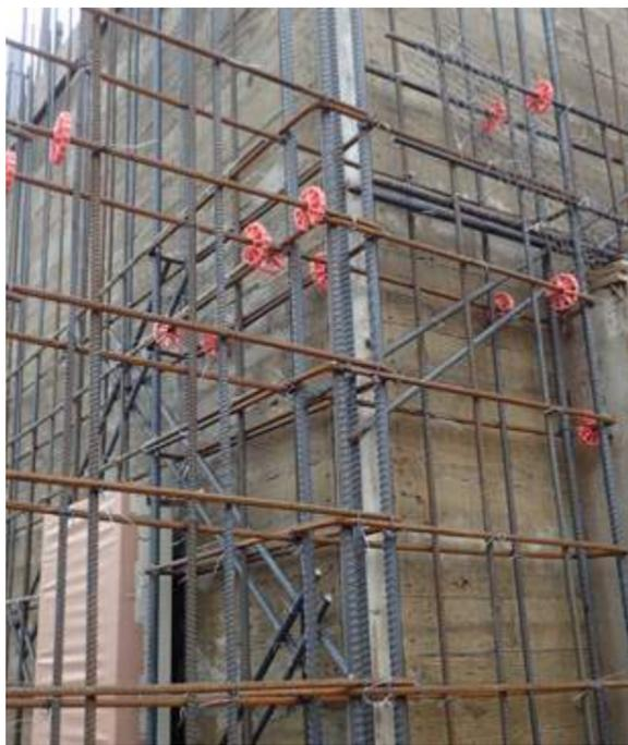
上二圖 / L 型系統牆箍加強圍束牆筋
