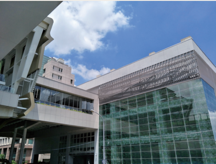
圖 / 台中捷運綠線 G9 站，交通局提供。
