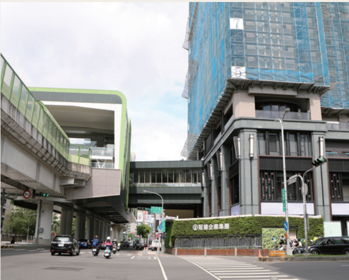
圖 / 台中捷運綠線第一棟與捷運共構的聯合開發案，首推台中文心、河南路口的 G8 站，投資合作人冠德建設。G8 站聯合開發工程，興建地上 28 層、地下 6 層的店鋪及集合住宅大樓，預定 2020 年 12 月 21 日完工。
