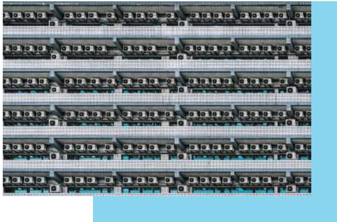
圖 / 整齊排列的室外機，實際上在運行時會造成熱氣短循環，大幅降低運轉效率。
