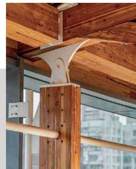
圖 9 | 集成木構樑柱接頭
