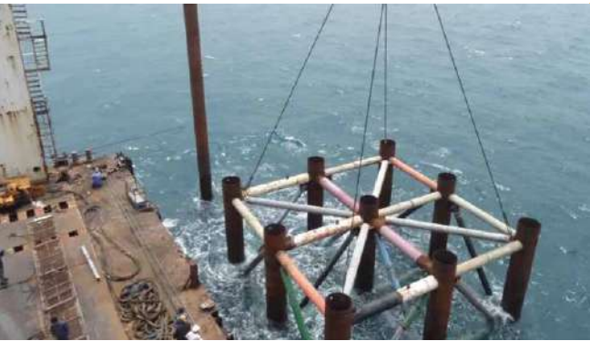
圖 | 離岸風電工作船出海，安裝水下基礎建設 - 上緯新能源影片截圖
