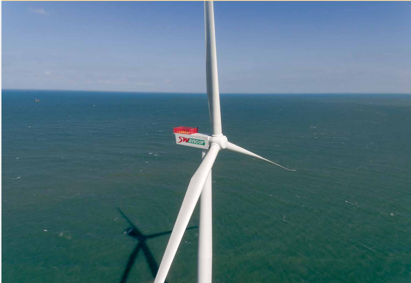
圖 | 二座示範風機吊裝完成 - 上緯新能源
