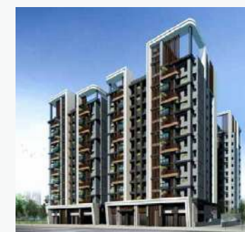
富宇建設 | 富好 敦富一街、近敦富路
