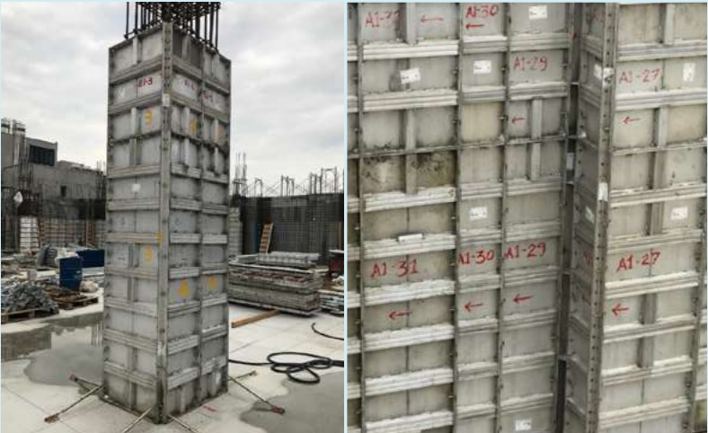
圖 / 鋁模板組立，每塊須依標示編號安裝在正確位子
