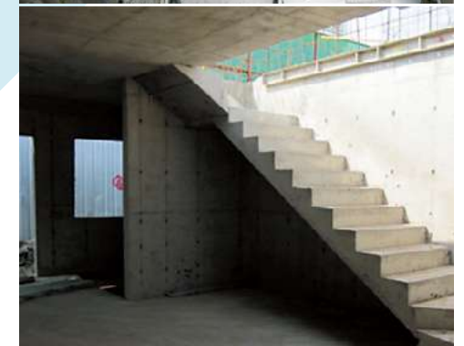
圖 / 樓梯鋁模板組立完成、鋁模板拆模後
