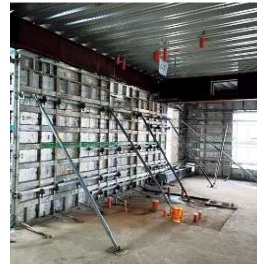
圖 / 廣慈博愛園區工程內牆模與內強拆模後
